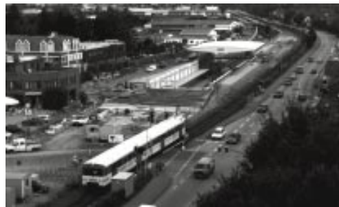
Der Trog in Henstedt-Ulzburg: Einer der letzten Züge auf der alten Strecke Foto: AKN
