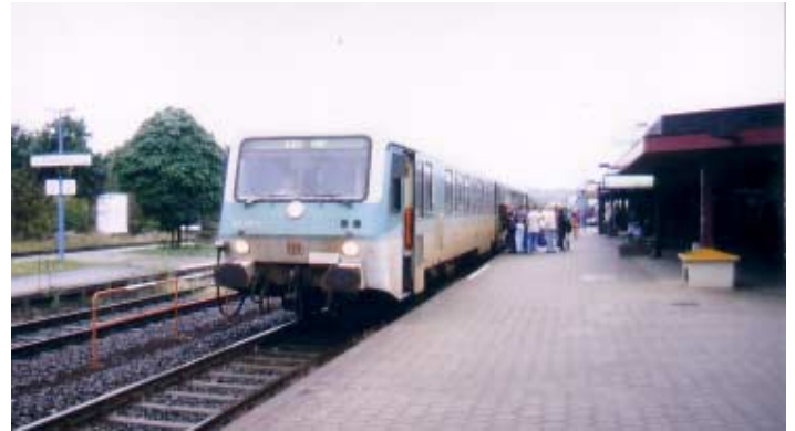
Wird auch demnächst saniert: Bahnhof in Eckernförde Foto: Björn Maßheimer
