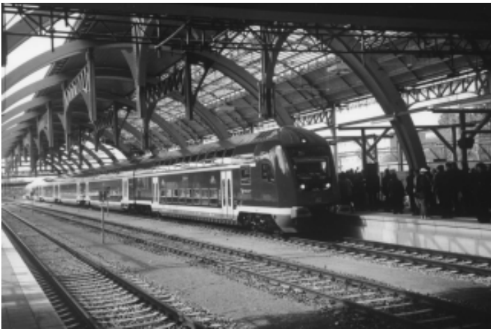
Der Premierenzug in der (noch unfertigen) Lübecker Bahnhofshalle Foto: G. Stoltze
