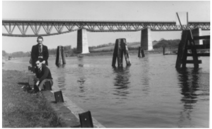
Die Brücke über den Elbe-Lübeck-Kanal (1953)
