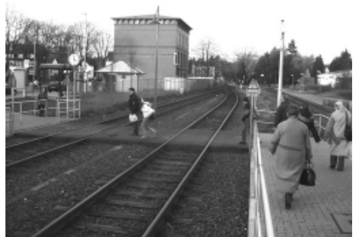
Kundenfreundlich: Bad Bramstedt; nur Sicherheitsgitter sichern den Übergang, für Fahrgäste bestehen keine unnötigen Wartezeiten.
