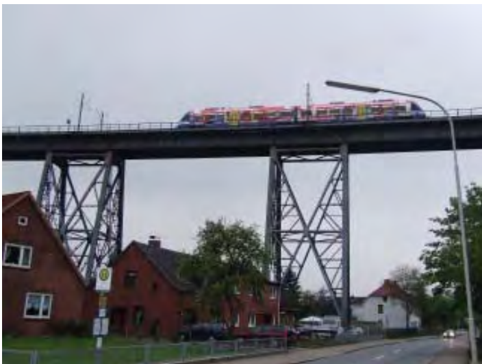
So nach und doch unerreichbar - Die schnelle Verbindung nach Kiel über Osterrönfeld. Eine Stadtbahn ermöglicht hier noch einen Bahnhof
